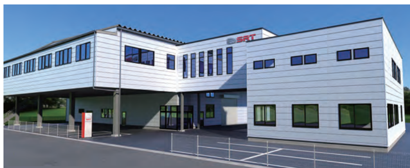
SRTテクニカルセンター(2025年2月開所)
